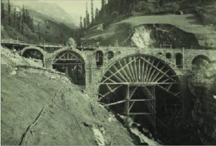
Das Dösenbachviadukt in Bau
